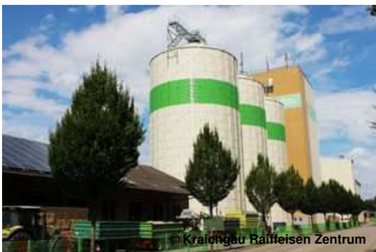
Lager und Verwaltung des Kraichgau Raiffeisen Zentrums in Eppingen
