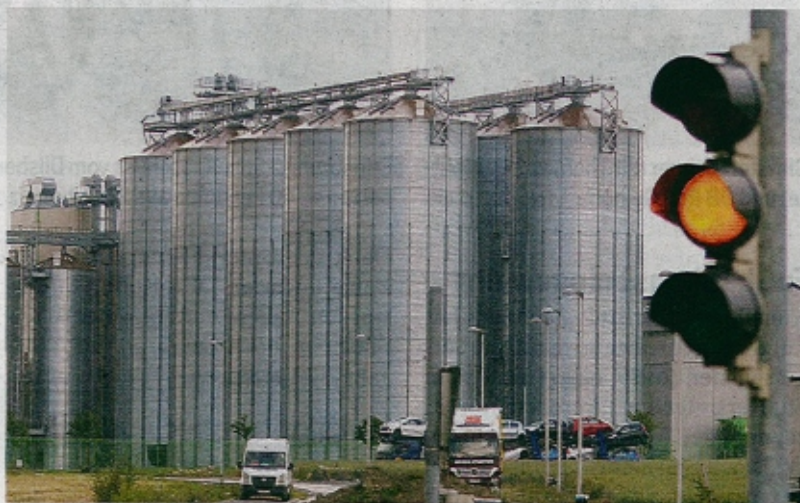
Die neuen Getreidesilos in den Buchäckern in Bonfeld, dem Standort Bad Rappenau des Kraichgau Raiffeisenzentrums Eppingen. Foto: Archiv/Maurhoff
